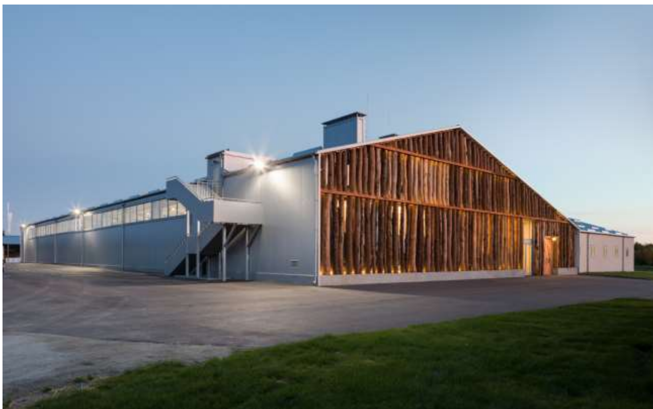
Рис. 2.4 Загальний вигляд адміністративного блоку. [1]
