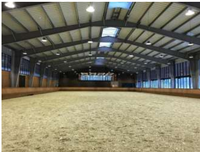
Рис. 6 Приклад влаштування критого манежу для верхової їзди з використанням збірних металевих конструкцій
