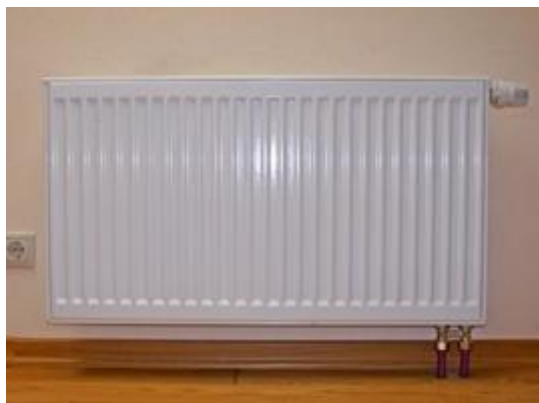
Рис.2.1. Зовнішній вигляд опалювального приладу Korado з нижнім підключенням типу VKL
