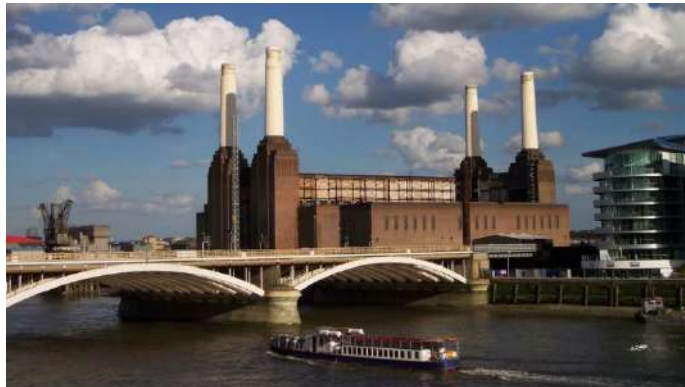
Рис. 1.2.3. Загальний вигляд на електростанцію[30].
