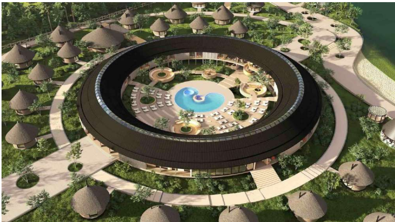
Рис. 2.25 Загальний вигляд Sandali Retreat [30]
