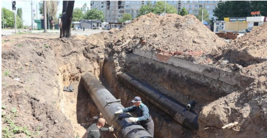
Рис. 3.5. Підземний газопровід
