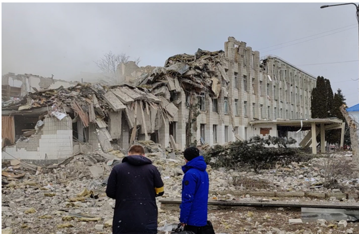
Рис.3.0. Фото будівлі станом на ранок 04.03.2022р.
