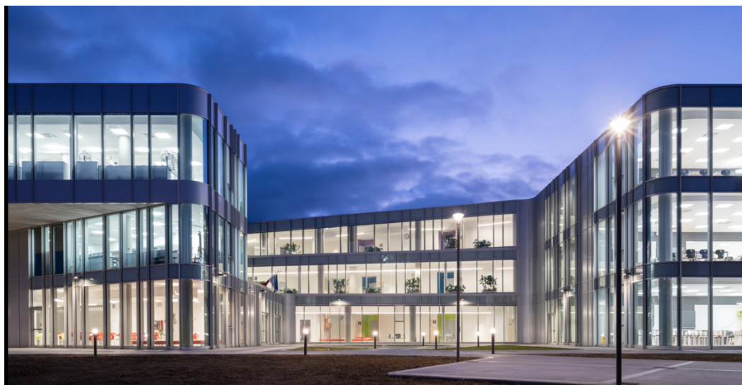
Рис.2.21. Західний фасад будівлі [ ]
