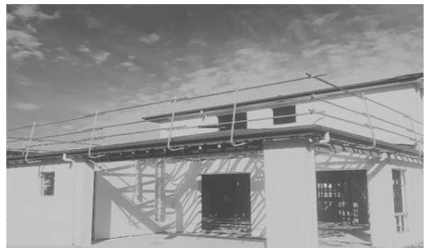
Рисунок 2. Огородження ділянки робіт за допомогою кріпильних систем
