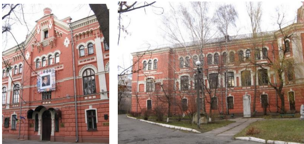
Рис. 4.3. Фрагменти фасаду Київської національної академії будівництва і архітектури [20]
