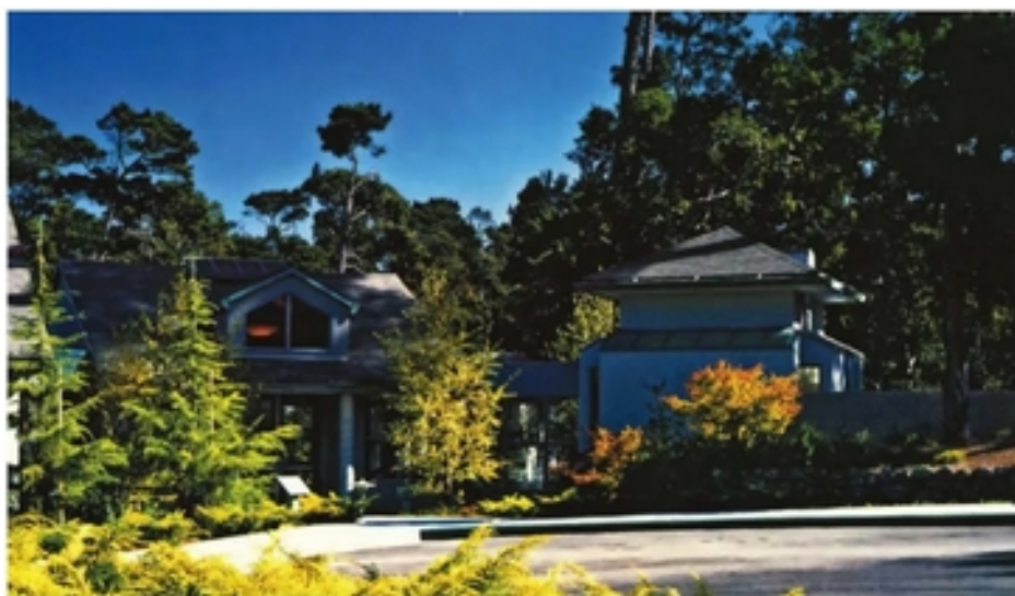
Рис. 1.2.27 Хоспіс Центрального узбережжя, Монтерей, Каліфорнія
