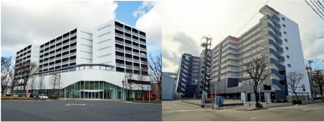
Рис. 2.5.22. 9-ти поверховий будинок з комерційними приміщеннями для ВПО в щільній забудові міста Сендай (2016 рік)
