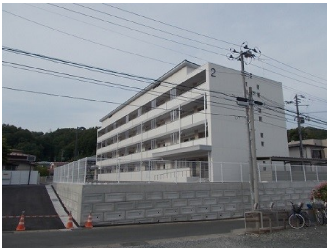
Рис. 2.5.11. 5-ти поверховий багатоквартирний житловий будинок (на 23 квартири) для ВПО в районі Нісімачі місті Міяко (2015 р.)
