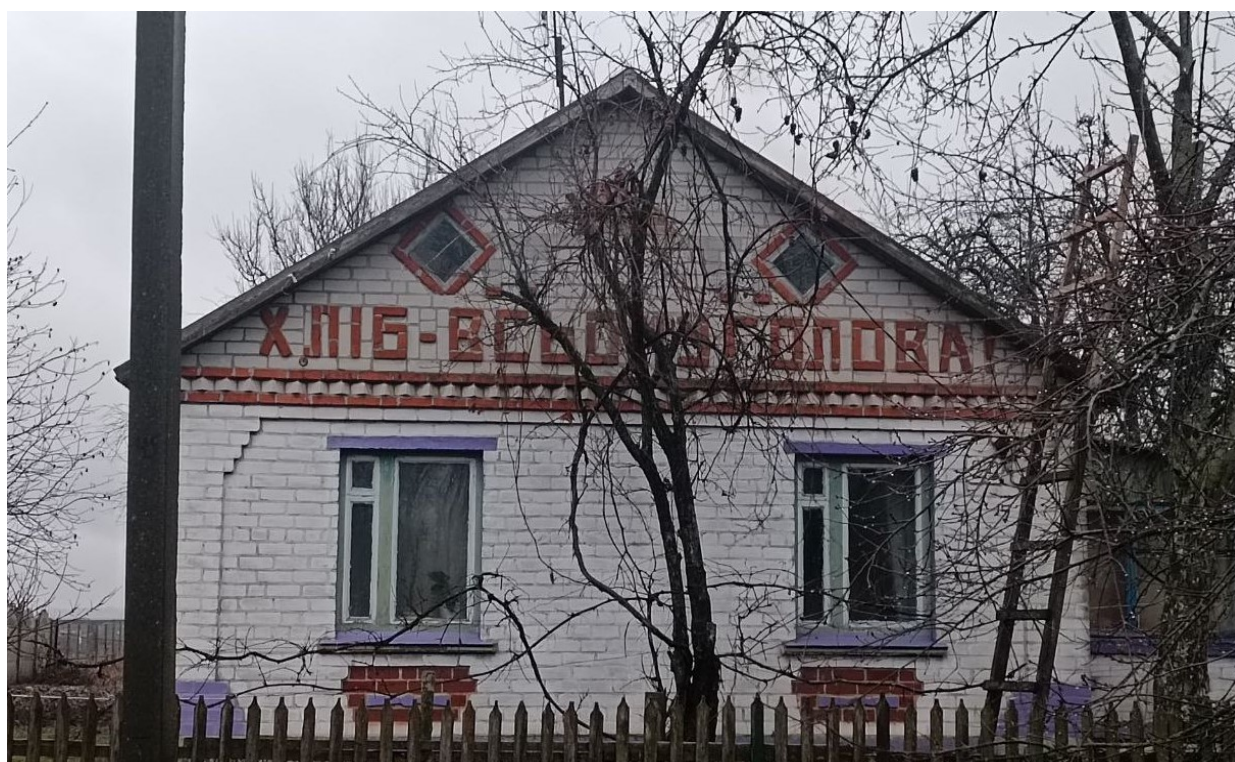
Рис. 1.2.1.12. Садибний житловий будинок за типовим проектом для ВПО постраждалих від наслідків аварії на ЧАЕС в селі Аркадіївка Київської області. (Натурне обстеження, 2022 рік)
