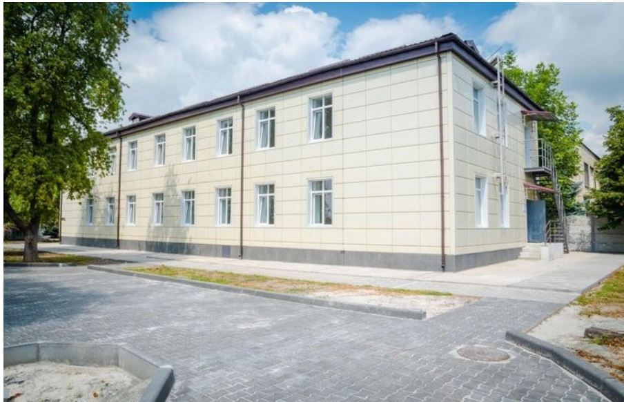
Рис.2.4.5. Будівля ДНЗ реконструйована під гуртожиток для ВПО (2019 р.) [44]
