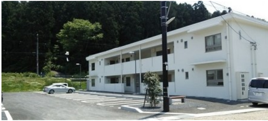
Рис. 2.5.24. Блокована будівля для ВПО в районі Ханокідайра в місті Сіракава (2015 рік)
