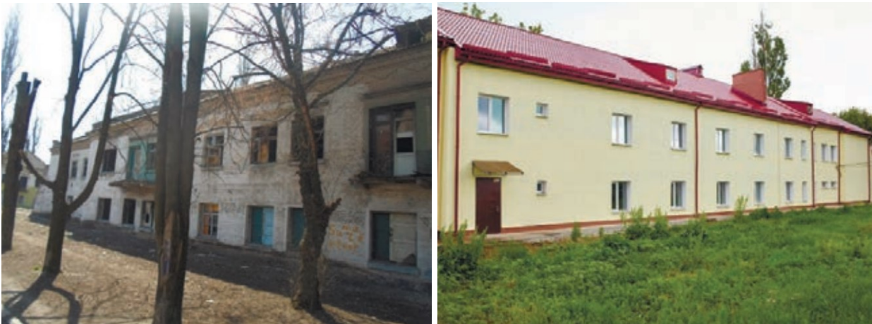
Рис.1.2.3.7. Житло для ВПО в Павлограді (Дніпропетровської області) до та після ремонту (2015-2019)
