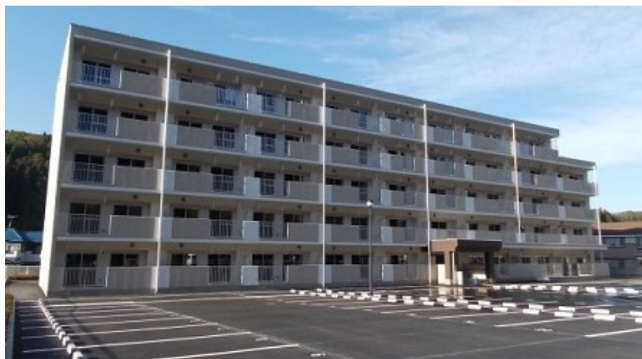
Рис. 2.5.14. 5-ти поверховий багатоквартирний житловий будинок (на 42 квартири) для ВПО в районі Ягісава в місті Міяко (2015 р.)
