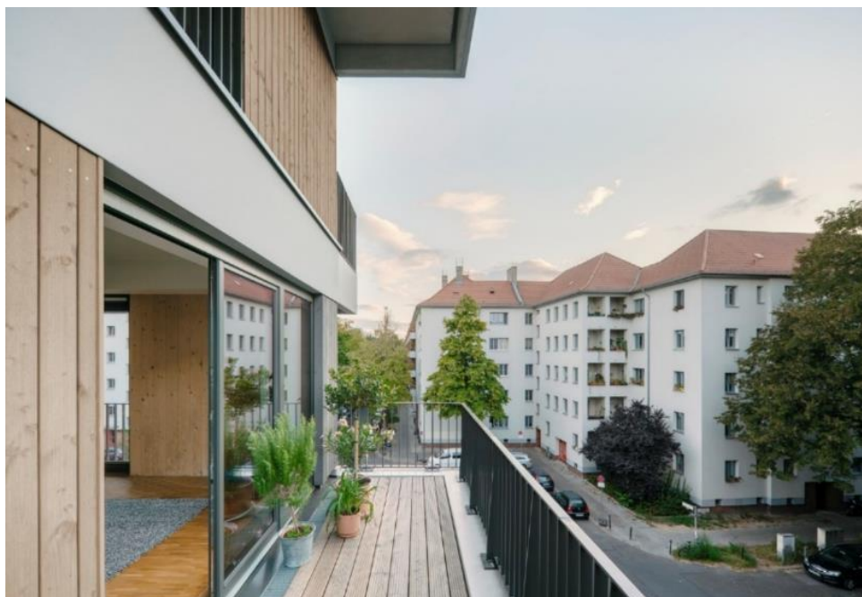
Рис. 2.5. Вигляд балконів будівлі [1]
