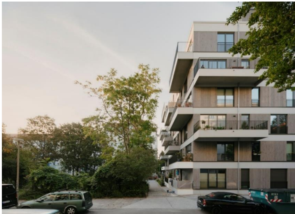
Рис. 2.4. Вигляд будівлі з торця [1]
