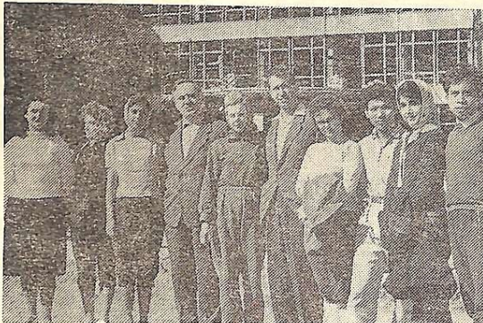
Будівництво головного корпусу. У центрі серед студентів ректор КІБІ Ю. О. Ветров. 1963 рік.
