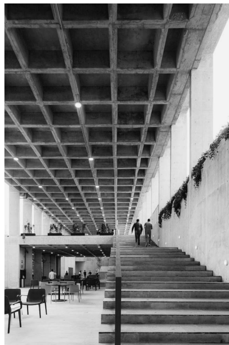
Зображення 43 Конструкції з монолітного залізобетону
