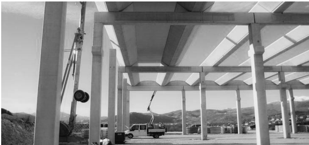
Зображення 44 Модель конструкцій з елементів збірного залізобетону
