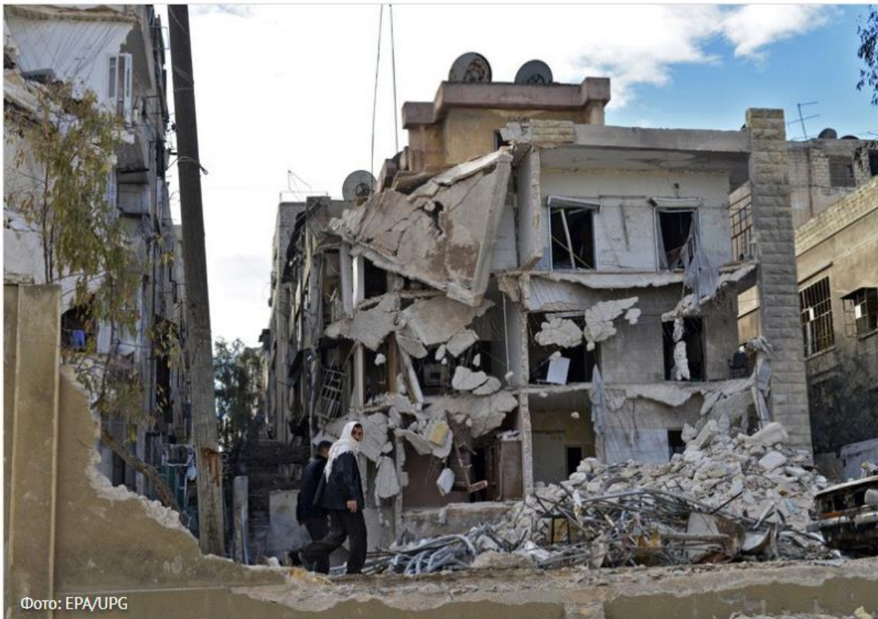
Зруйновані будівлі в районі Ансарі, Алеппо, Сирія, 26 лютого 2014 року.
