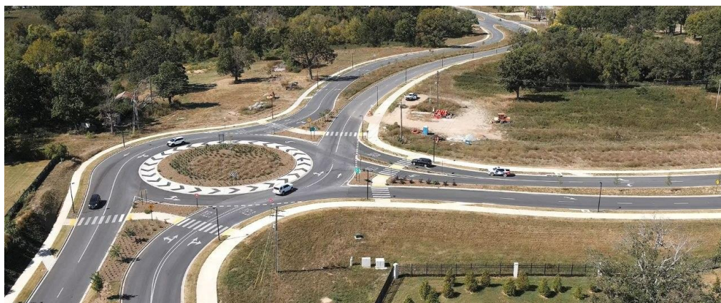
Рис. 2.2 Приклад облаштування турбокільця з використанням острівців безпеки
