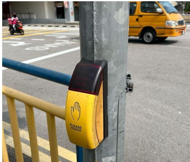
Рис. 2.4 Приклад облаштування сучасного доступного світлофора
