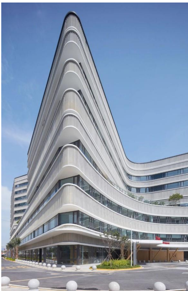
Рис. 2.10. Загальний вигляд відділення
