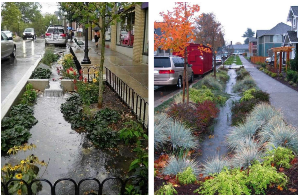
Рис. 6.6. Приклади реалізації біодренажної системи в міській забудові
