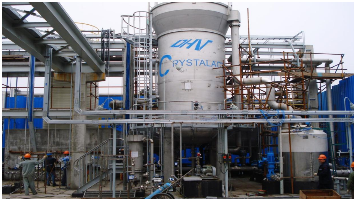
Рис. 2.1 Застосування Crystalactor на підприємстві
