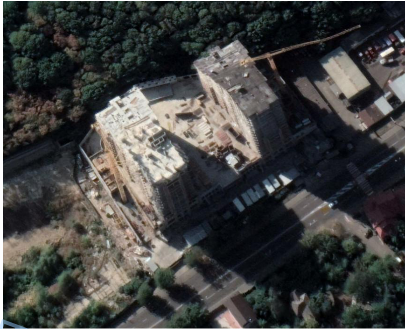
Рис. 1. Зображення будівництва на супутниковому знімку.
