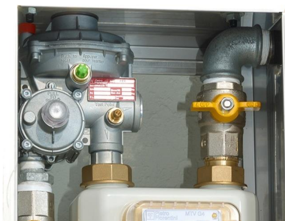
Рис. 1.4 Регулятор тиску Pietro Fiorentini FE 25 ВР
