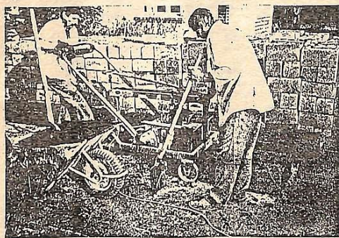
Мал. 3. Механізований пересувний віброверстат для виготовлення будматеріалів (в роботі).
