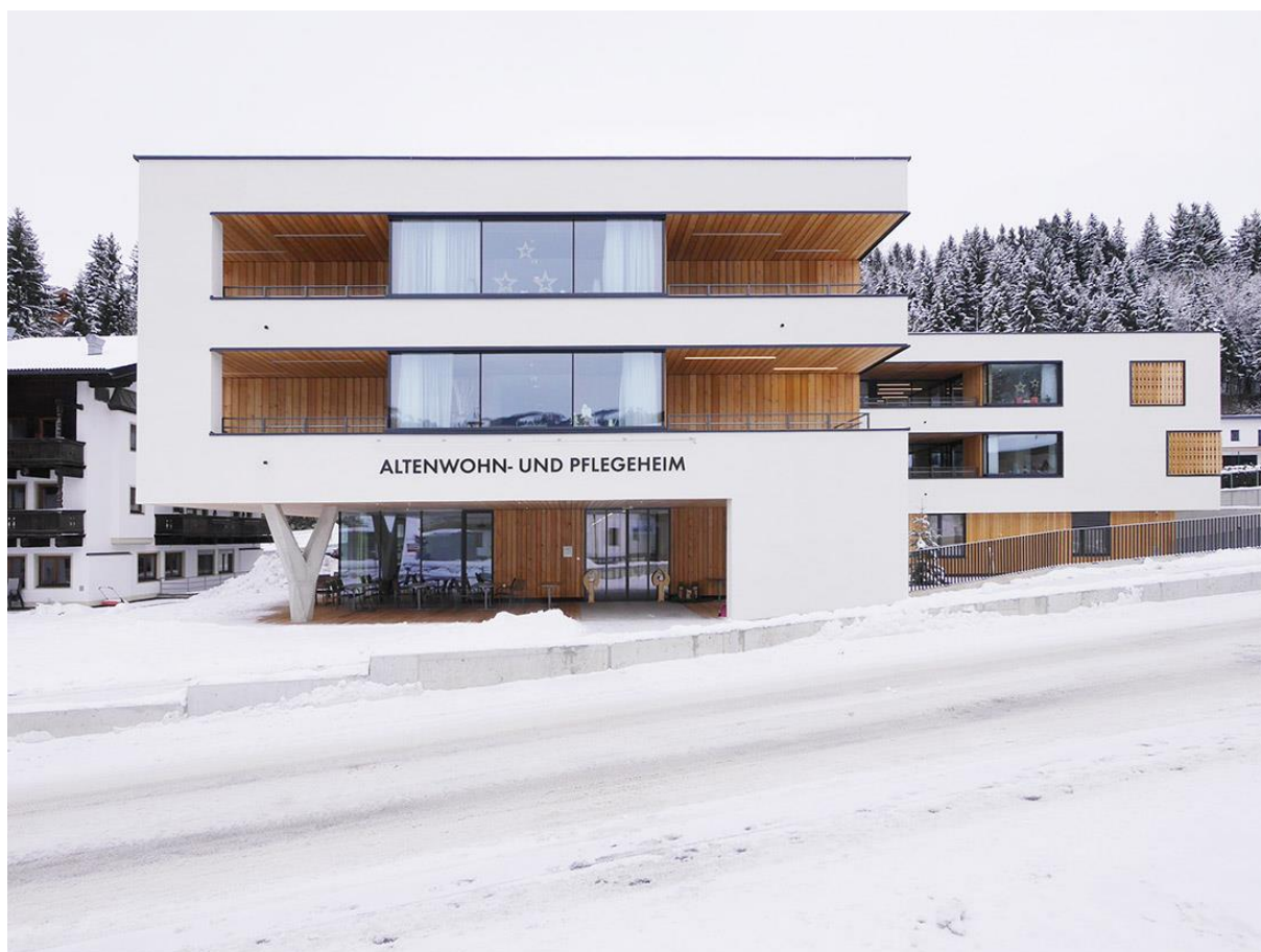
Рис. 2.4 Головний фасад будівлі
