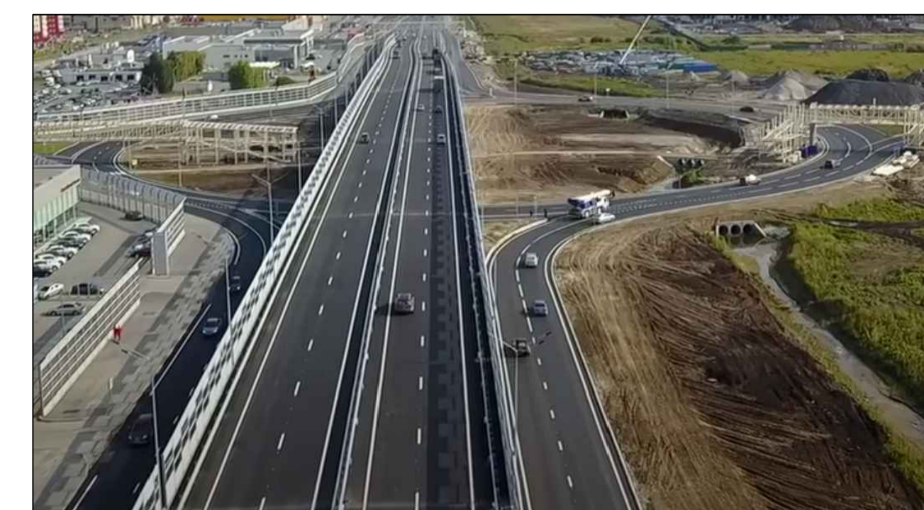
Будівництво подібного вузла
