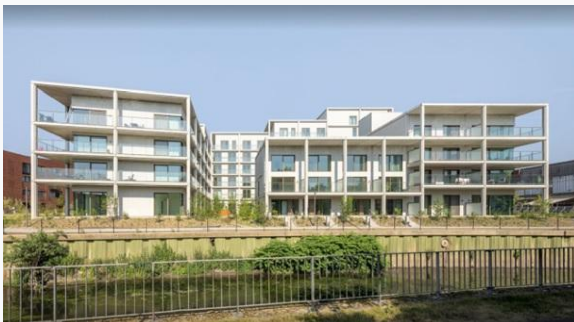
Рис. 2.42 Загальний вигляд зі сторони каналу
