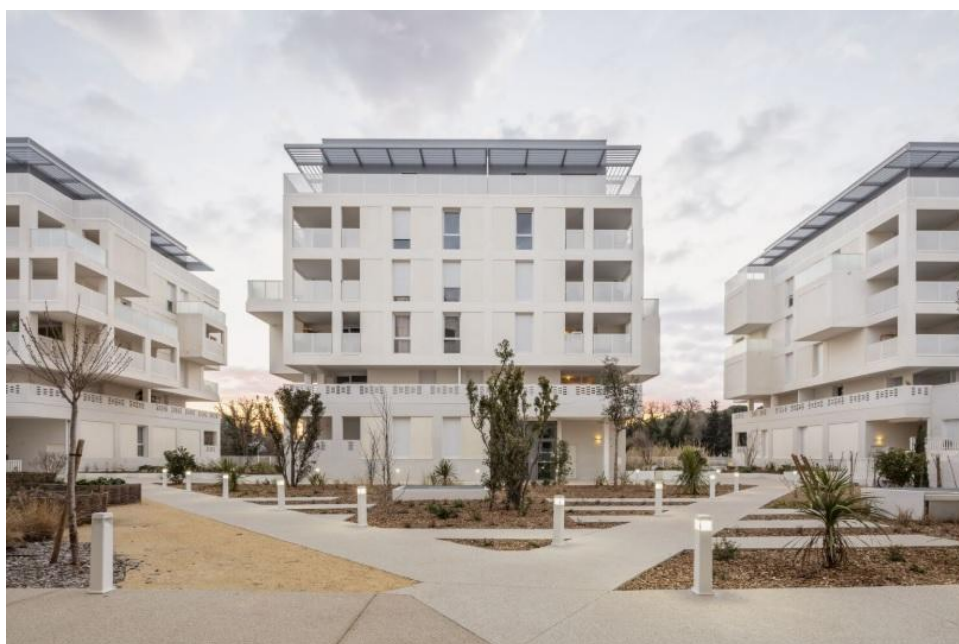
Рис.2.35 Загальний вигляд житлового комплексу
