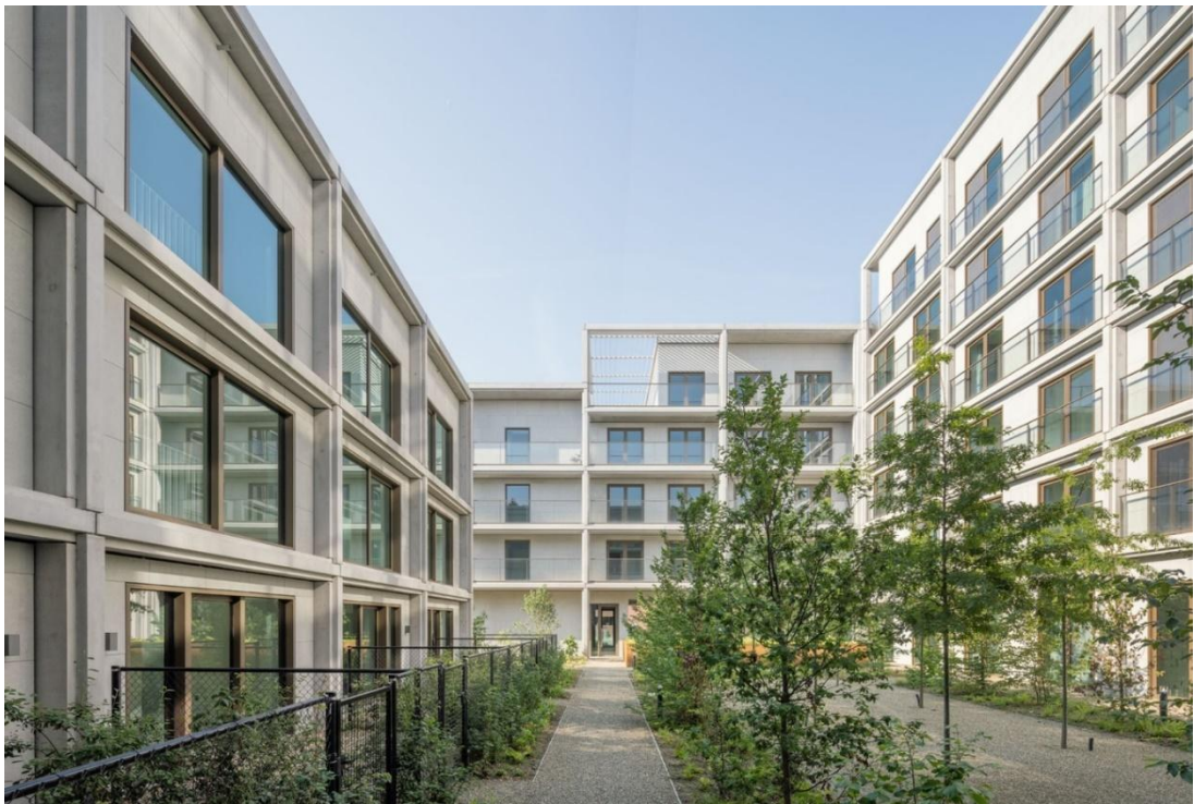
Рис. 2.53 Вид на внутрішній дворик
