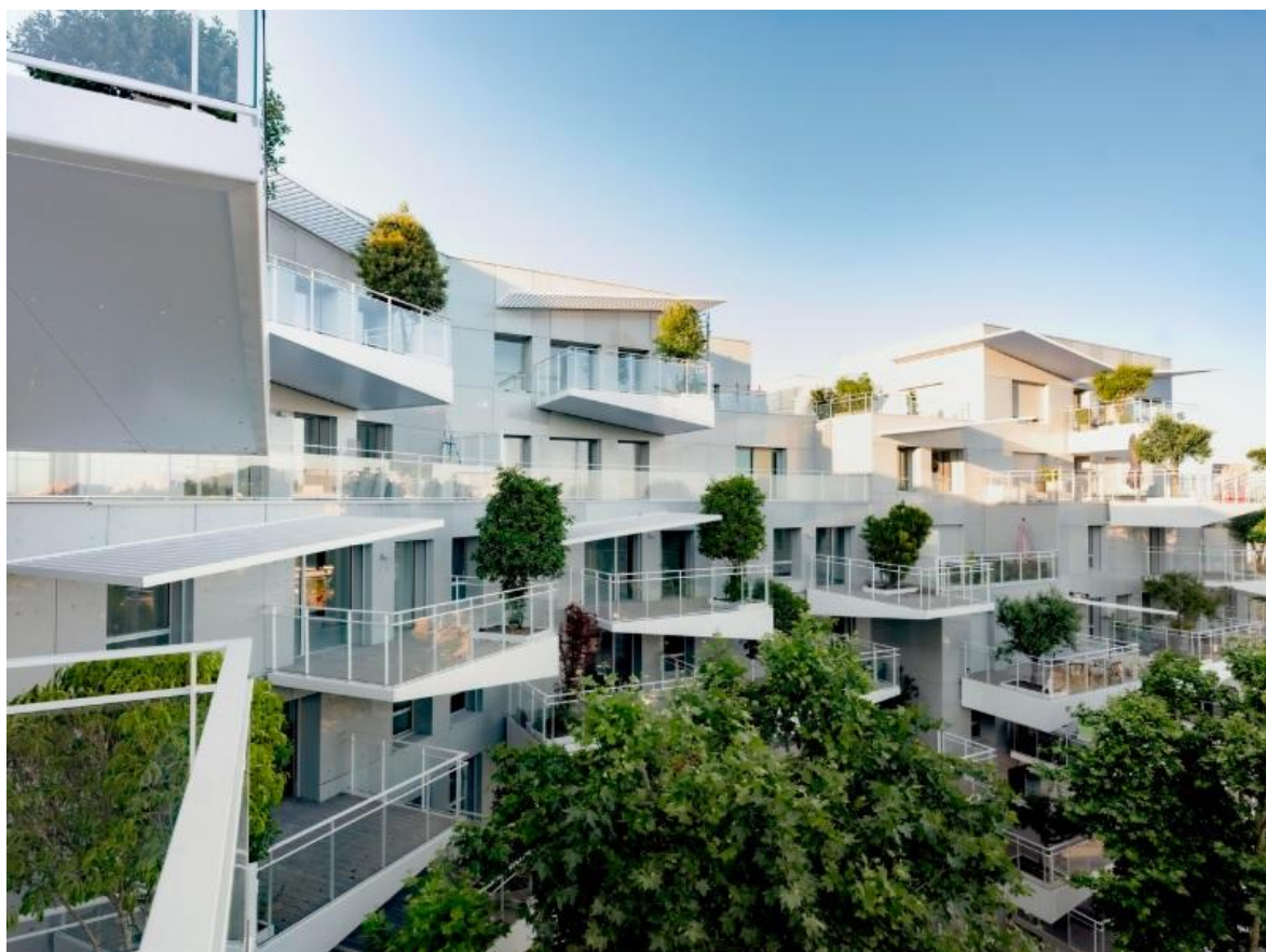
Рис.2.34 Вид на внутрішній дворик
