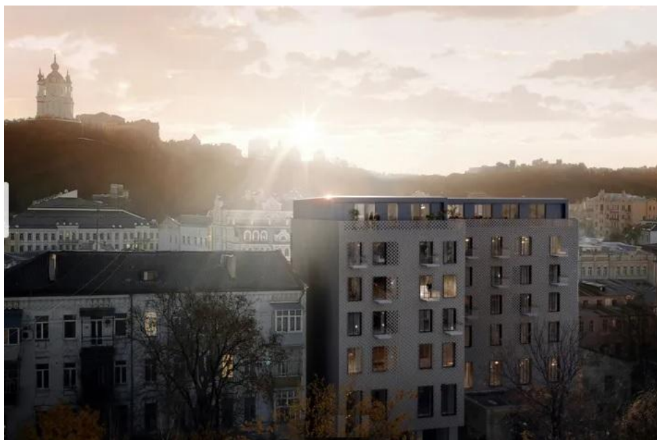
Рис. 2.3 Загальний вигляд житлової секції.
