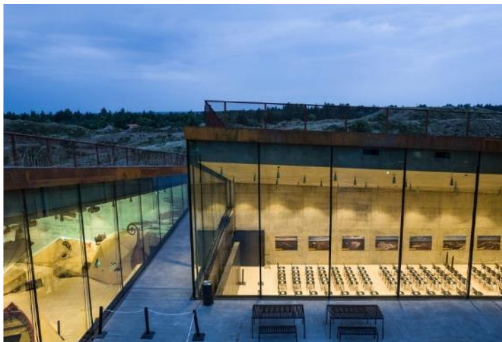
Рис. 2.16. Внутрішній простір із галереями [14]
