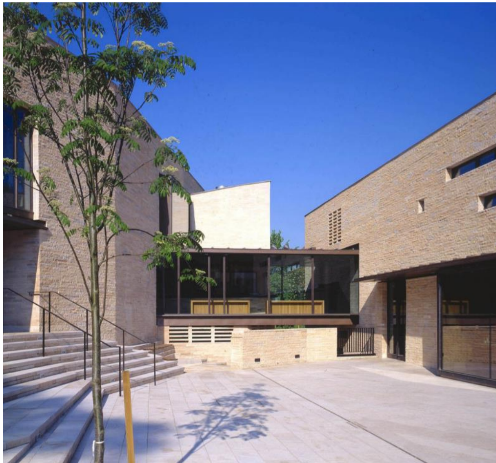
Рис. 2.21. Північна частина будівлі – двір [15]
