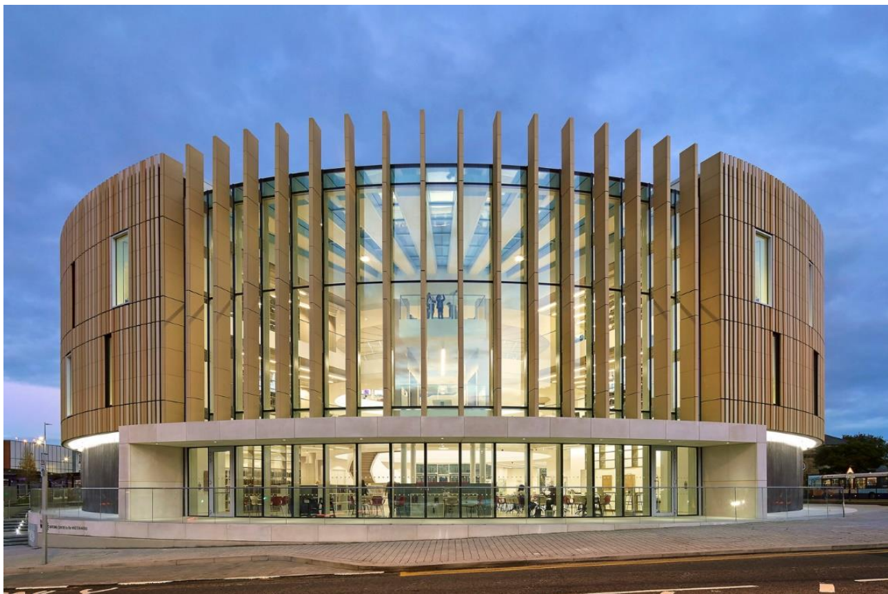
Рис. 2.6. Загальний вигляд будівлі The Word – National centre for the written word [23]
