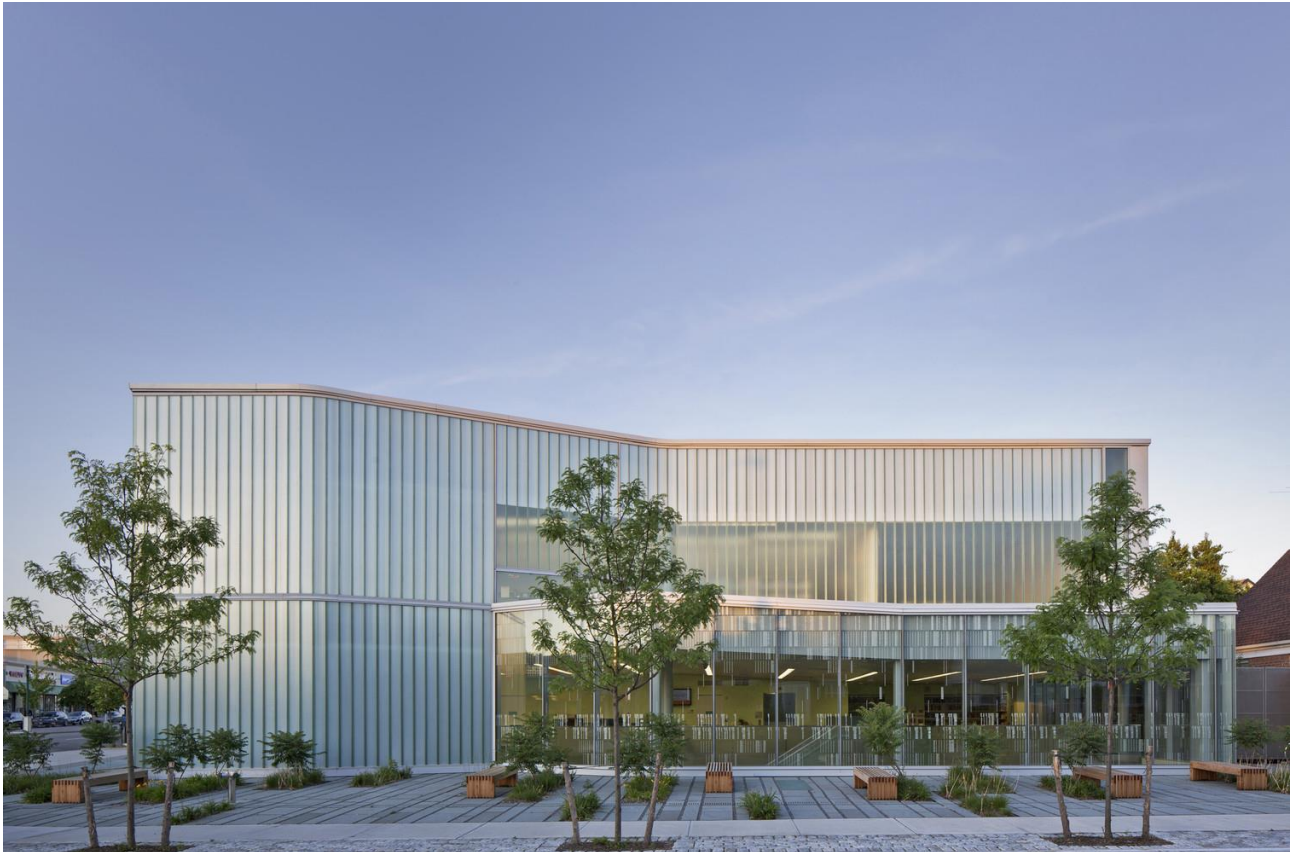
Рис. 2.9. Загальний вигляд будівлі Glen Oaks Branch Library [26]
