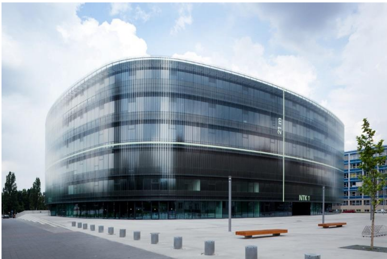
Рис. 2.11. Загальний вигляд будівлі National Technical Library in Prague [28]
