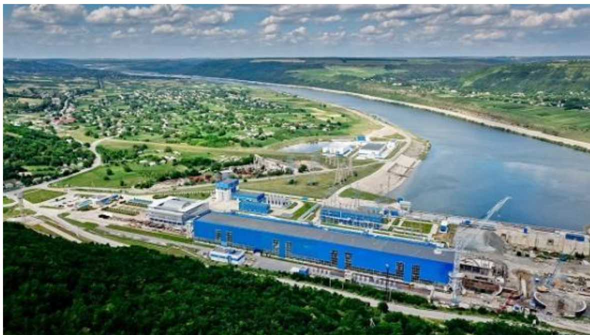
Рис.1.5. Будівлі Дністровської ГАЕС та буферне водосховище
