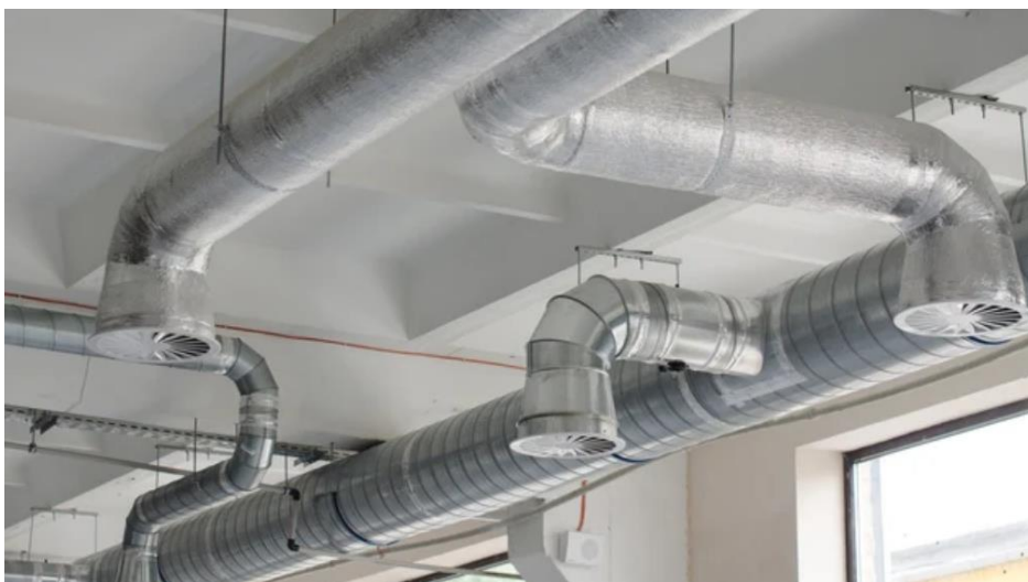
Рис 7.3. Повітроводи повітряного опалення [27]
