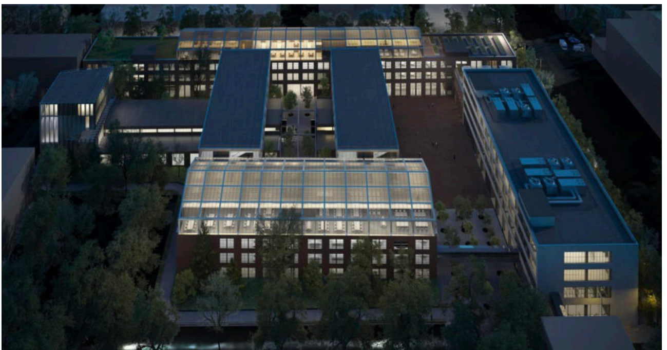
Рис. 2.21 «Центр інноваційних технологій Промприлад Реновація», Вид на будівлю зверху. [9]
