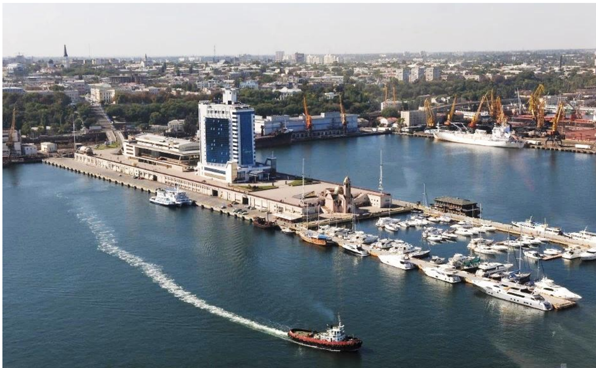
Рис. 2.6. Загальний вигляд комплексу [27]
