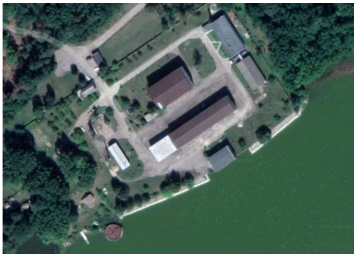
Рис. 2.1. Міський водозабір КП «Житимирводоканал»
