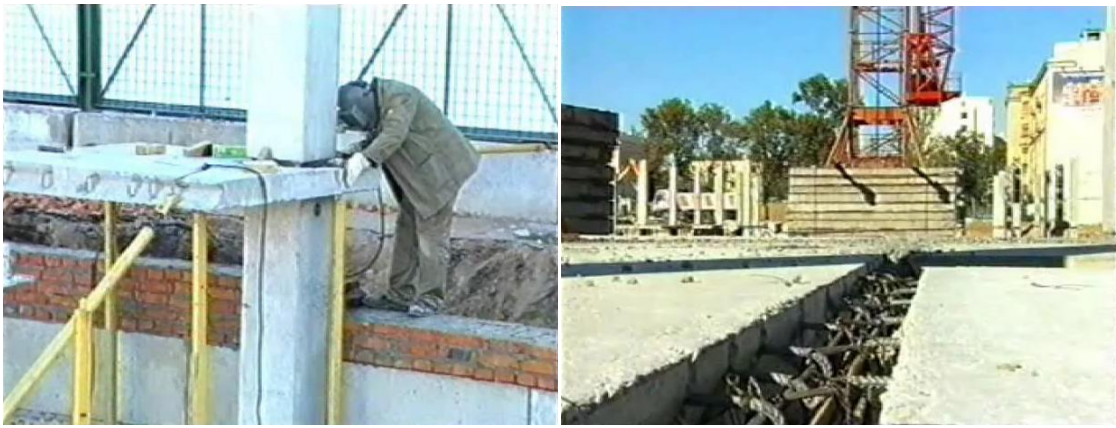
Рис.9. Вигляд елементів надколонних плит і стиків між плитами і з колонами в процесі монтажу.
