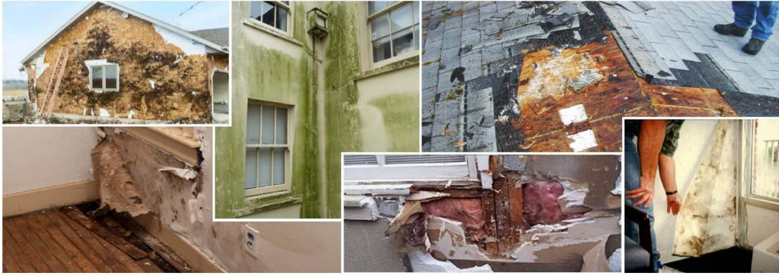
Рисунок 2. Проблеми проникнення вологи в огорожувальні конструкції будівлі (Джерело: DOE Emerging. Дорожня карта технологій, 2019).
