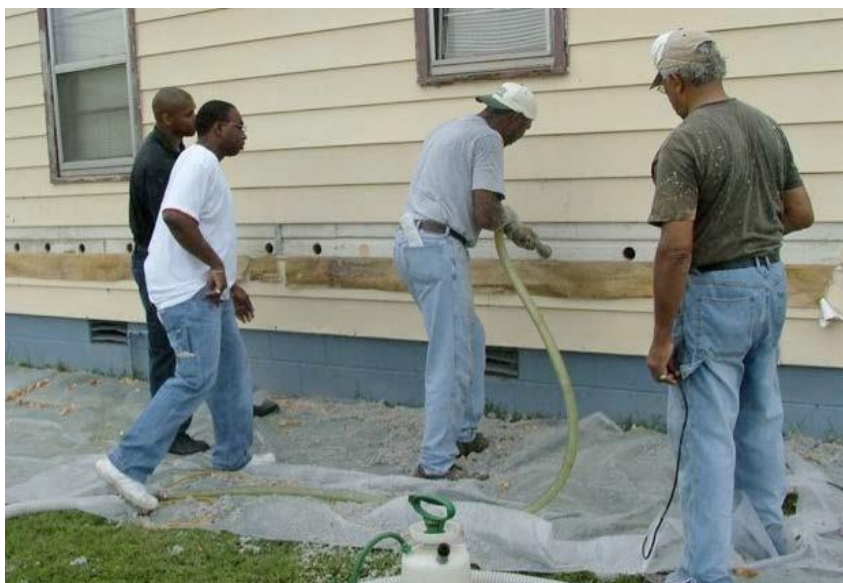
Рисунок 3. Модернізація зовнішньої стіни житлового будинку методом буріння та засипання
