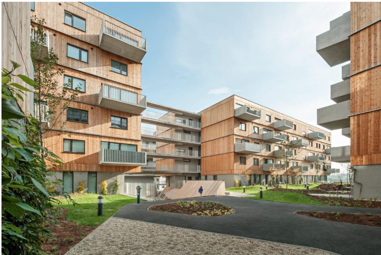
Рис. 2.7. Загальний вигляд комплексу [5]
