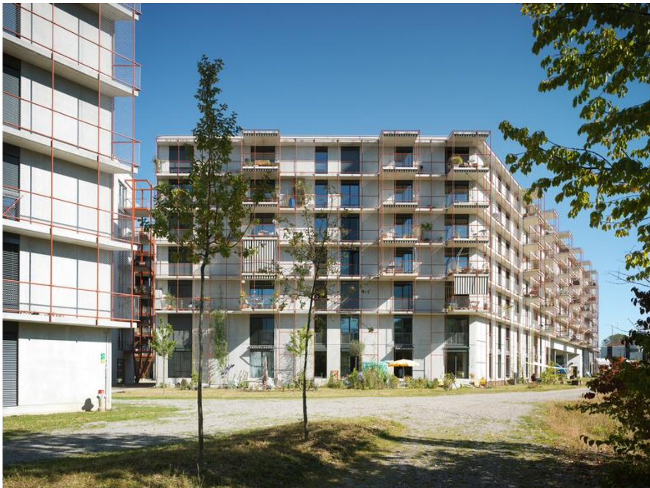
Рис. 2.3. Загальний вигляд комплексу [4]
