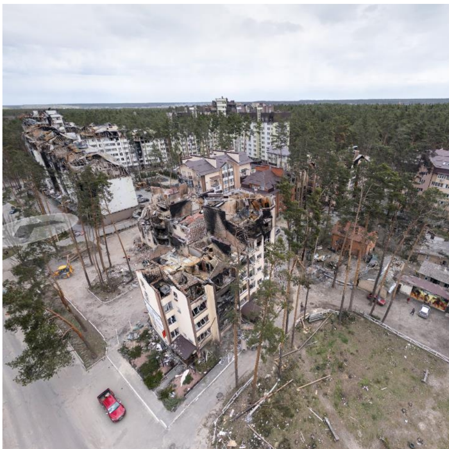
Рис. 3.5. Зруйновані будівлі на ділянці (2022р.)[7]
