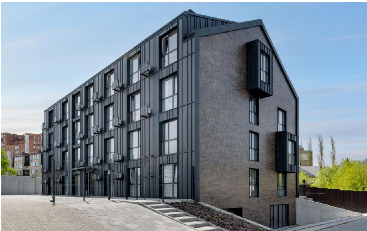
Рис. 2.2. Загальний вигляд будинку [3]
