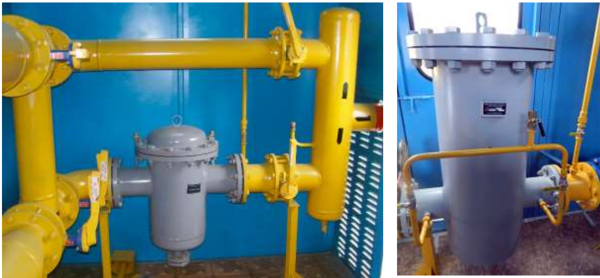
Рис. 11. Приклад розміщення фільтра газового ФГ
