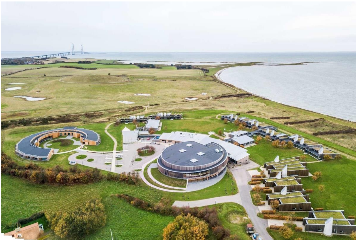
Рис. 2.1 Загальний вигляд комплексу
