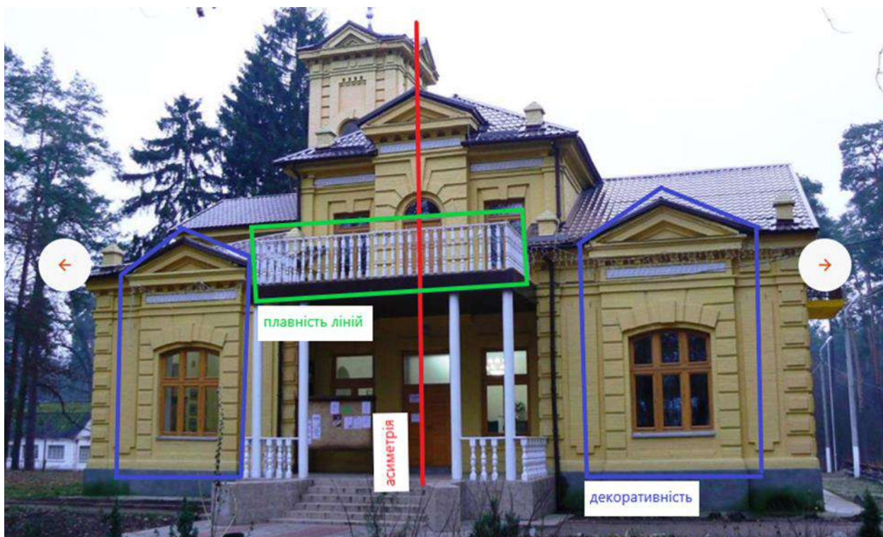
Рис.4.3. Будівля Центру культури “Уваровський дім” [52]
