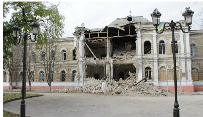
Пошкоджений ліцей імені М.Аркаса в 500 метрах від університету (вул. Нікольська, 34)
