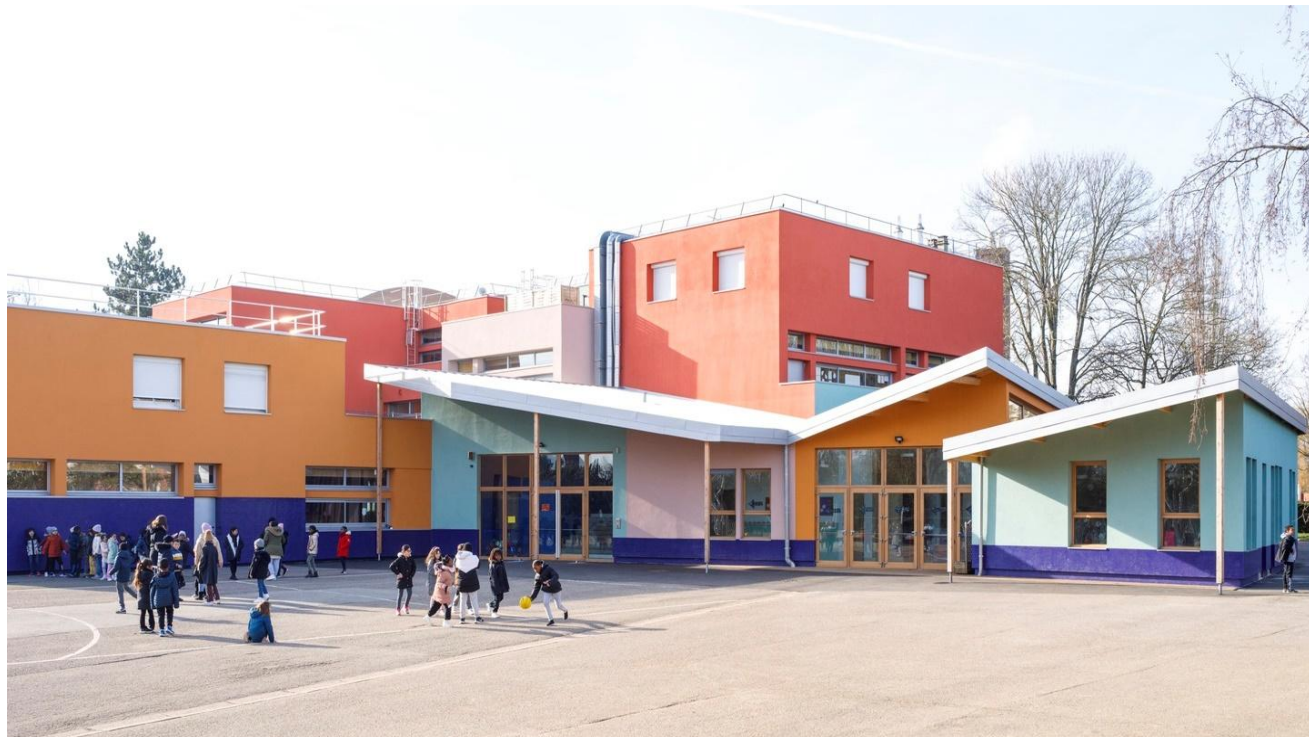
Рис.2.2.17 Загальний вигляд школи в м. Трап. [23]
