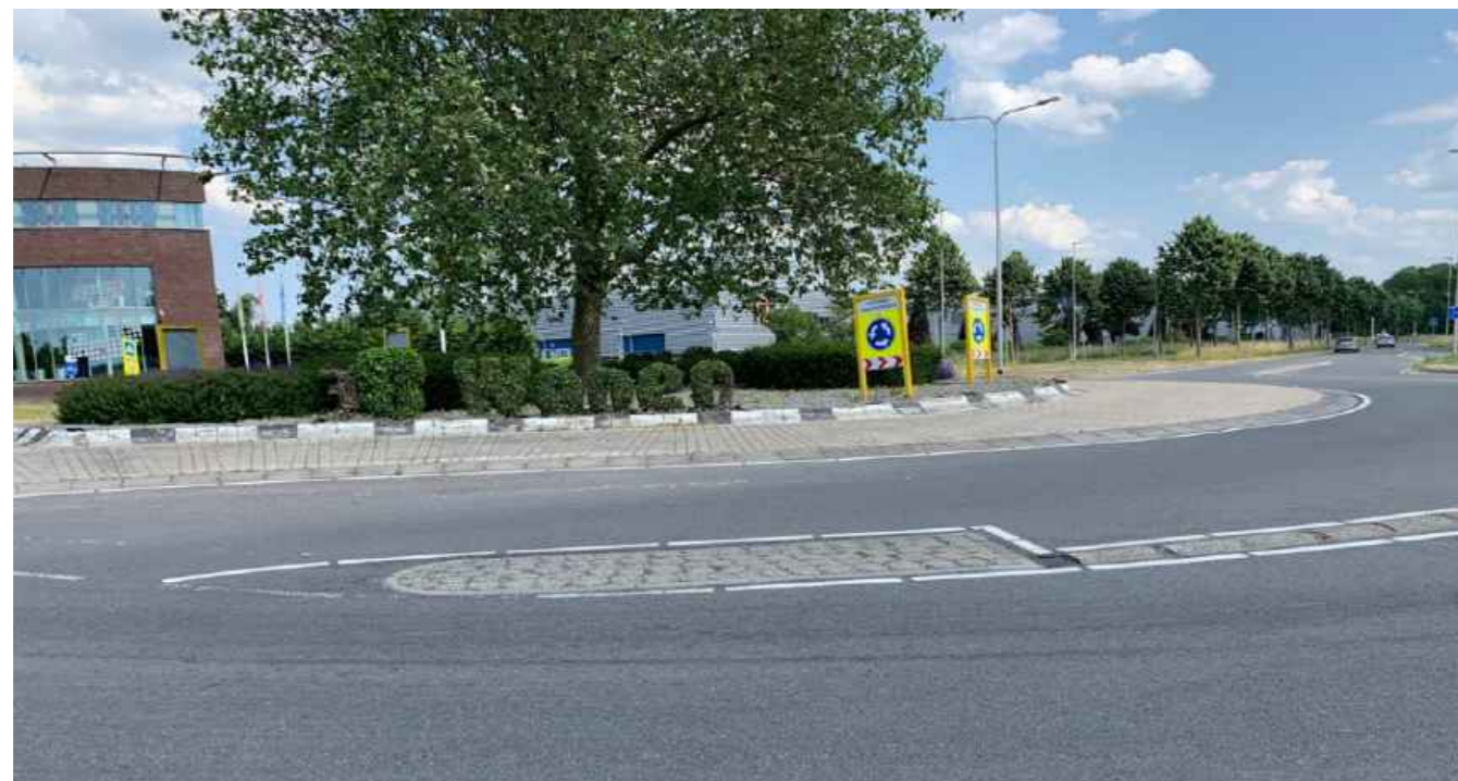
Підняте каналізування на кільцевій дорозі на заокругленому центральному острові внутрішньої смуги руху в Нідерландах (Джерело: Федеральна австралійська адміністрація)
