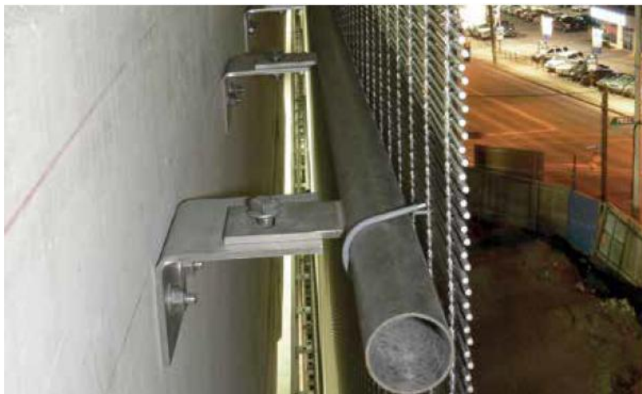
Рис.6.2 Фрагмент кріплення сонцезахисту [23]
