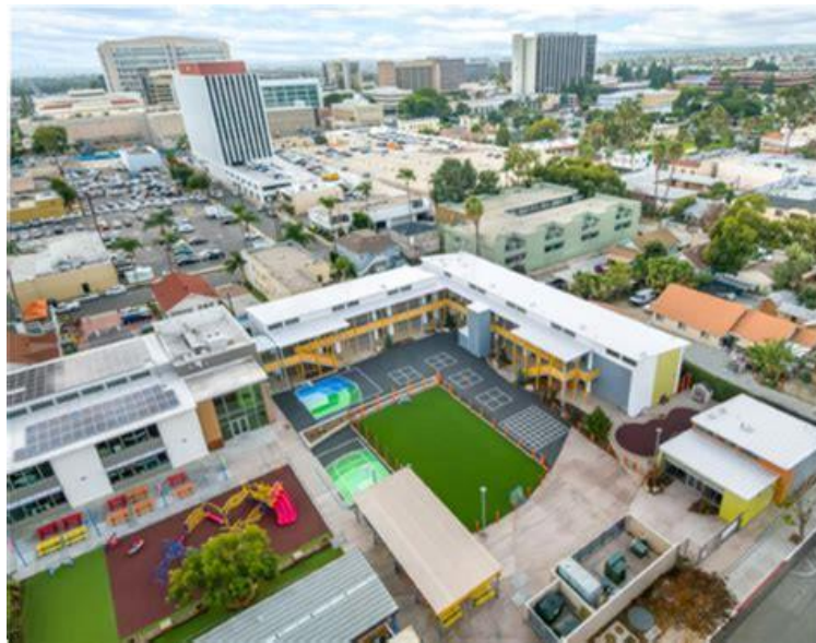
Рис. 1.5. Знімок (зовнішній вигляд будівлі з висоти): демонструє комплексне рішення – два поверхи, модульна збірка, відкриті дитячі зони
