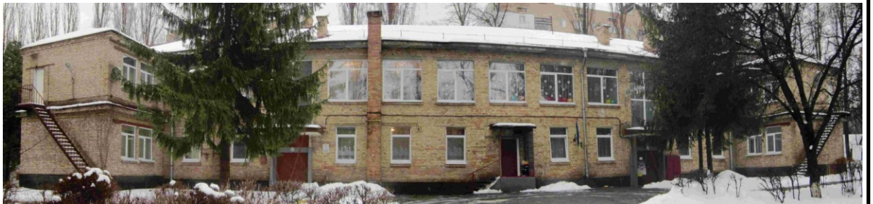
Дворовий фасад будівлі в осях Е/18-1 і Д/16-4
