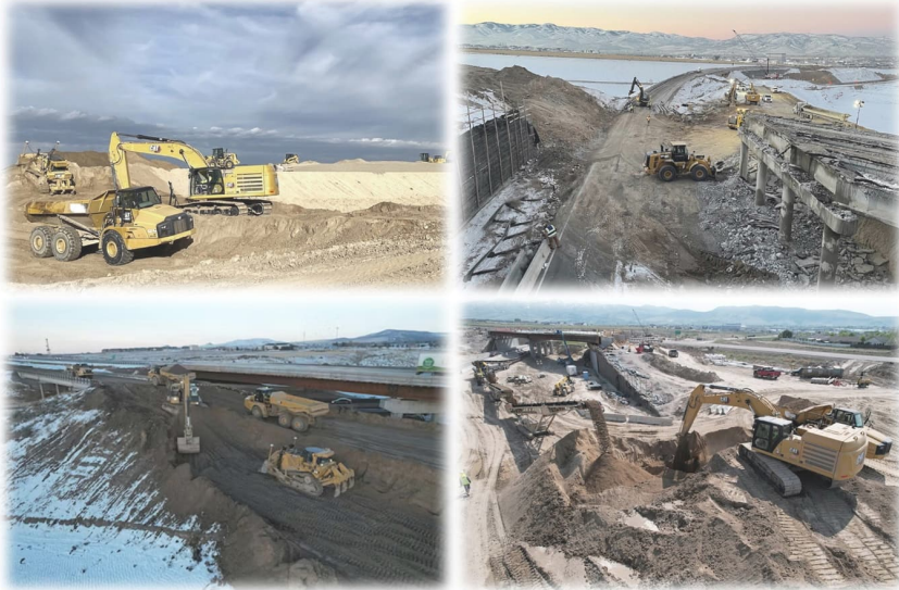
Рис. 5.1. Потоковий комплексний метод виконання земляних робіт
