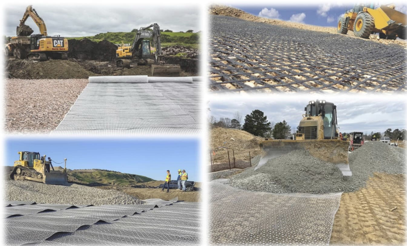
Рис. 6.1. Застосування геосинтетичних матеріалів у земляних спорудах
