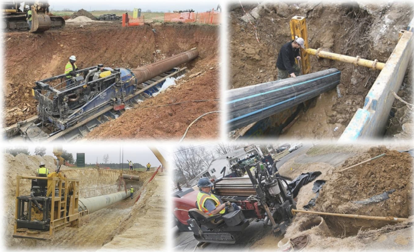
Рис. 4.10. Технології безтраншейного прокладання інженерних мереж
