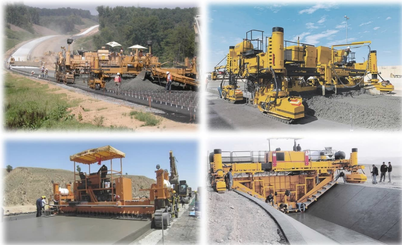
Рис. 5.6. Приклади будівництва цементобетонних покриттів
