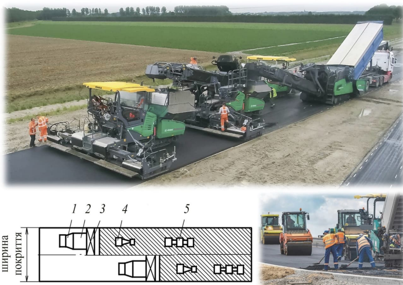
Рис. 5.5. Технологія будівництва асфальтобетонного покриття:
