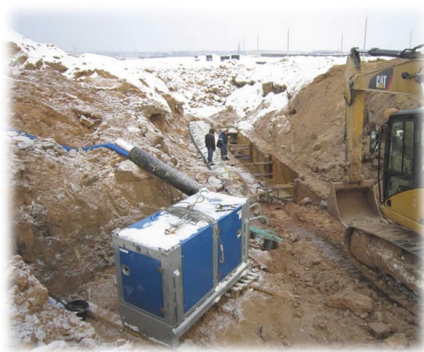
Рис. 2.9. Схема і приклад реалізації відкритого водовідливу:
