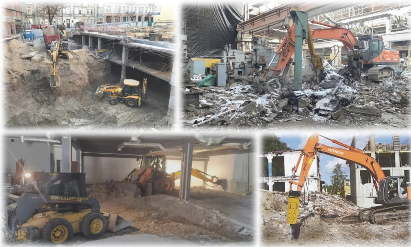
Рис. 4.1. Виконання земляних робіт в умовах обмеженого простору
