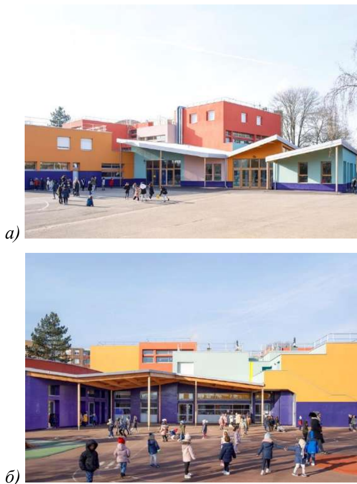
Рис. 1.3.8. Школа Jean Macé, Архітектор: SOL architecture and urbanism, Рік: 2022, м. Трапп, Франція: а) фасад будівлі, б) внутрішній двір [52].
