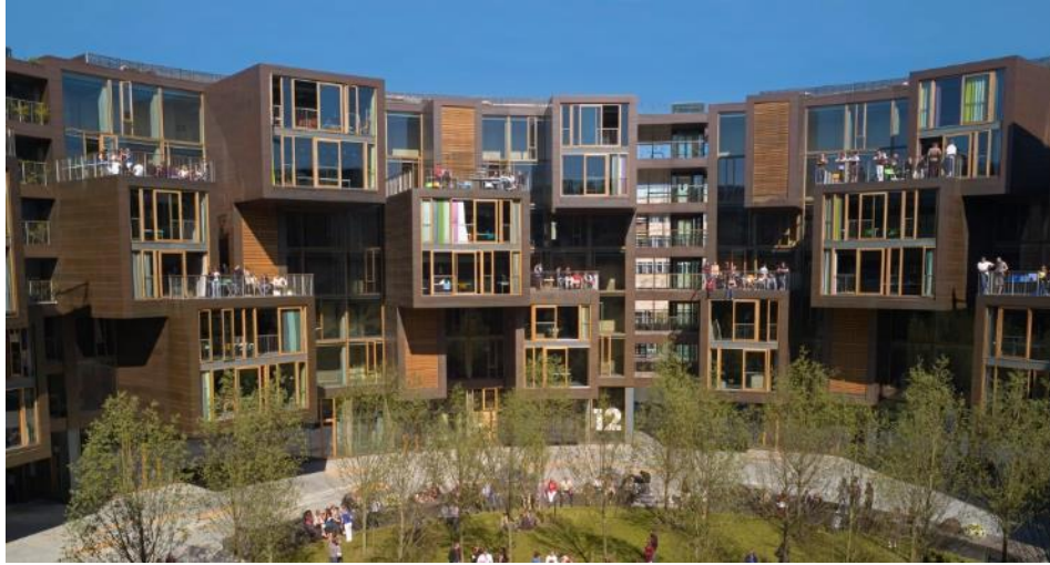
Рис. 2.16. Внутрішній простір гуртожитку [3]
