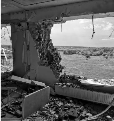
Рисунок.1 Часткове руйнування цегляного перестінку
