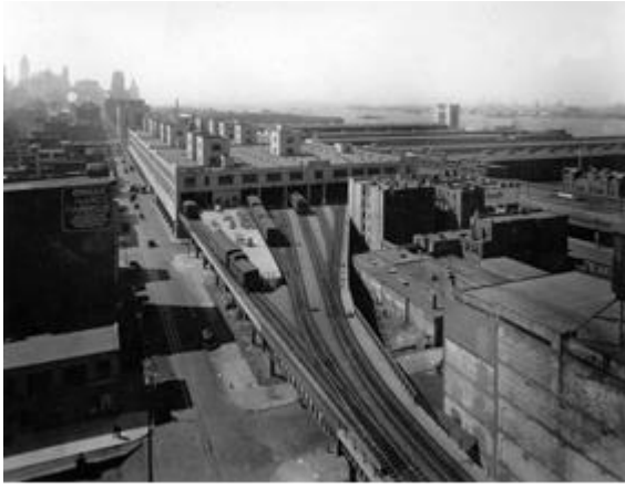
Рис. 1.2.18. High Line, Нью-Йорк, США до реконструкції [17]
