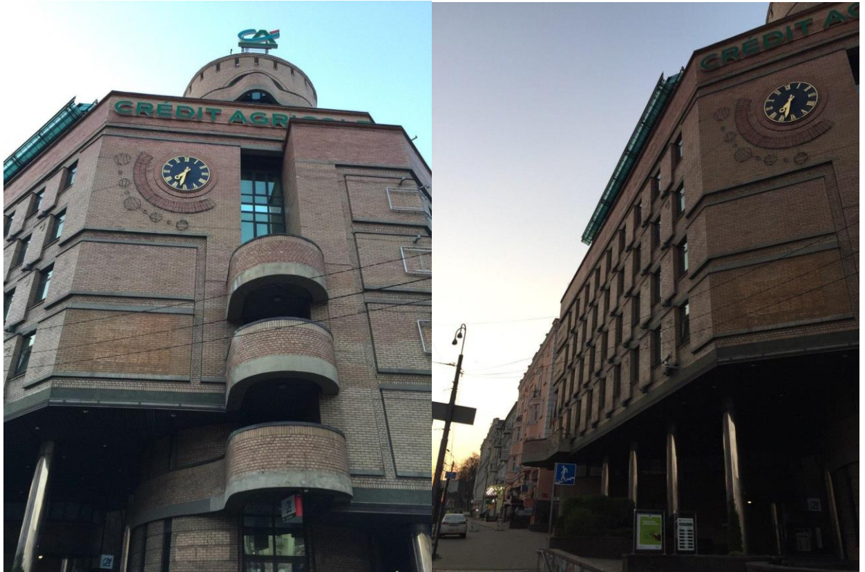
Рис. 6. Фотофіксація будівлі, Євдокименко А.С., 2022
