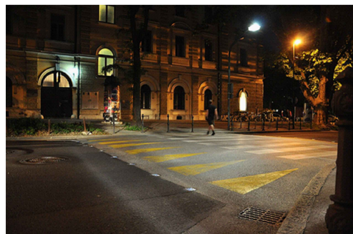
Підвищений пішохідний перехід з додатковою контрасною підсвіткою.
